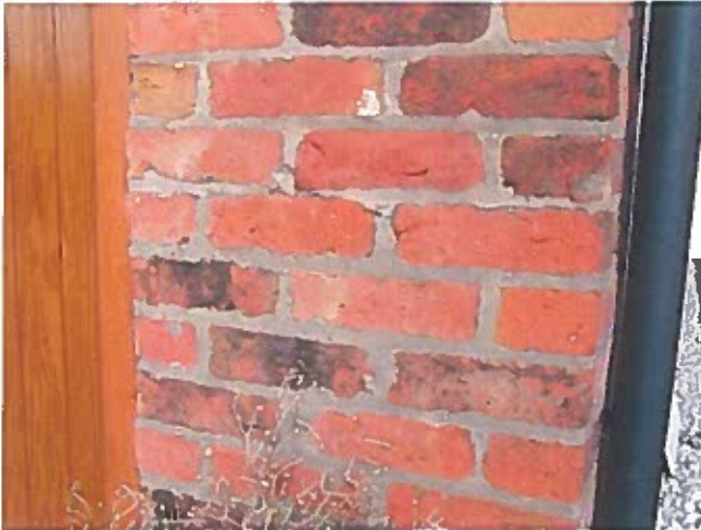
EXT WALLS 1.JPG
