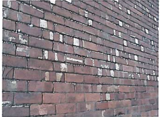
EXT WALLS 2.JPG
